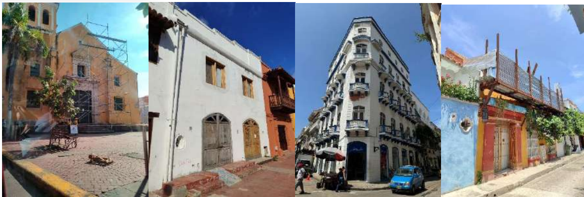
Registro: Detección de inmuebles y monumentos en deterioro
