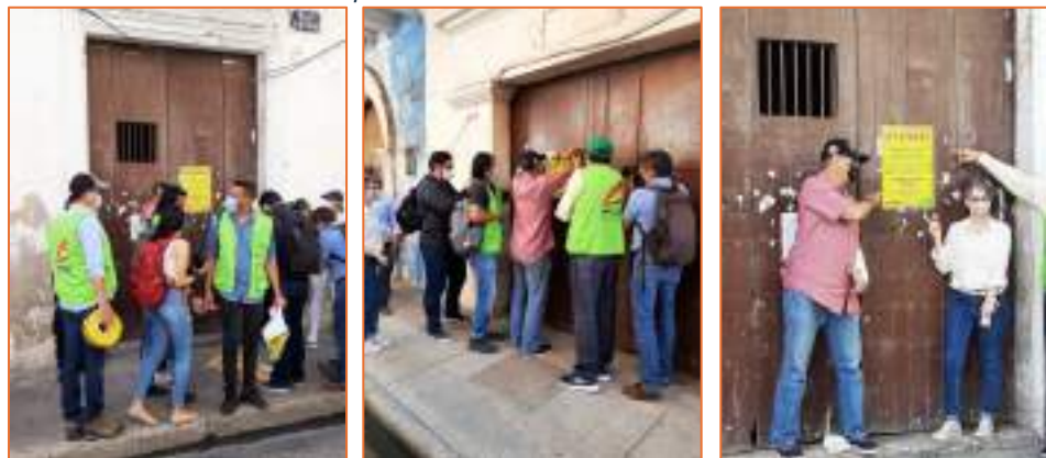
Ilustración 22. Primera campaña de señalización inmuebles en deterioro con el alcalde
